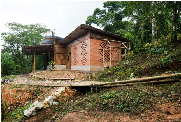
Figure 28 Vivienda en Puebla, Mexico Comunal Taller de Arquitectur
