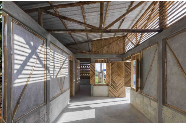
Figure 29 Vivienda en Puebla, Mexico Comunal Taller de Arquitectur
