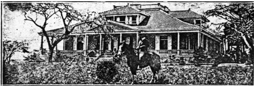
Fig. 12 Casa del Francés, Vieques, PR
